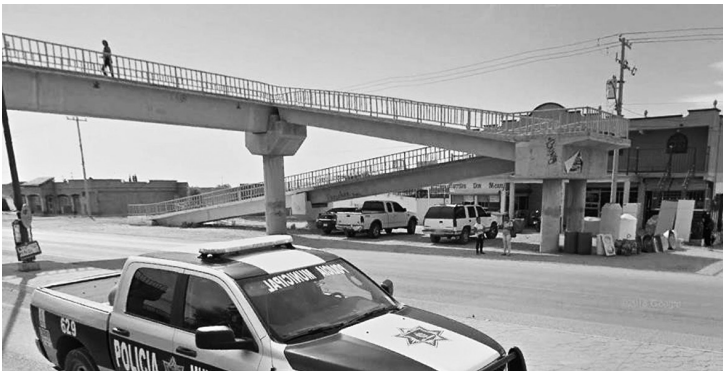
Fotografía 5. Puente peatonal en la carretera Juárez-Ascensión.
