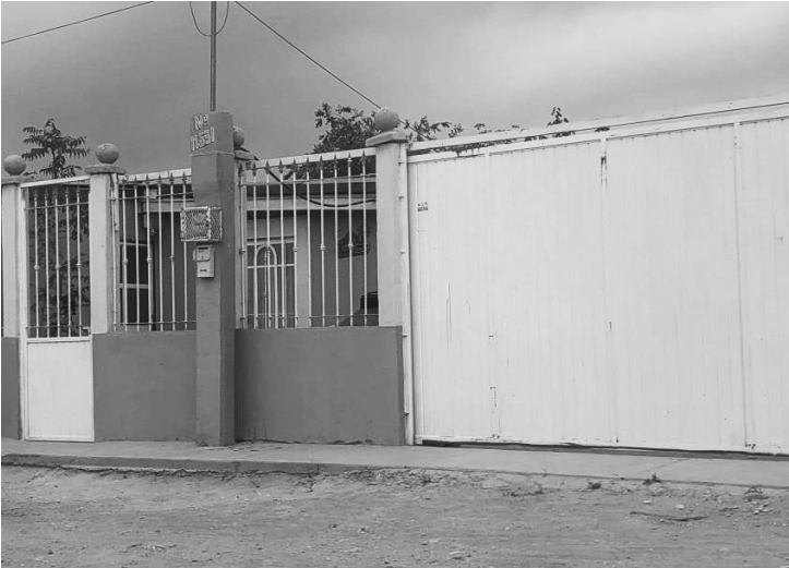
Fotografía 1. Vivienda construida de block con techos de madera y lámina
