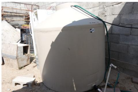
c. Tanque de 2 500 L para almacenamiento de agua desalinizada
