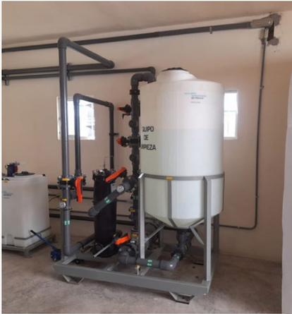
**FIGURA 8.** Bastidor de membranas y tablero de control con telemetría de planta de ósmosis inversa de 150 m<sup>3</sup>/d al 26 de noviembre de 2021
