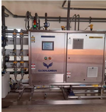
**FIGURA 9.** Sistema de dosificación química en planta de ósmosis inversa de 150 m<sup>3</sup>/d al 26 de noviembre de 2021
